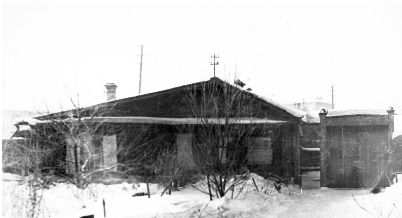
Дом А. М. Ахимблита, в котором члены бандгруппы, возглавляемой В. Коровиным, совершили убийство семи человек
